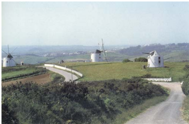
Fotografia III.10 A energia eólica é há muito utilizada na área metropolitana de Lisboa.
