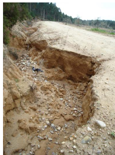
Fig. 2 – Ravina em expansão lateral ao longo de uma estrada. Freguesia de Ulme, Chamusca
