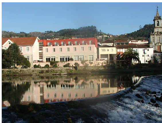
Fig. 9b – As construções urbanas problemáticas em Arcos de Valdevez, 2007.
