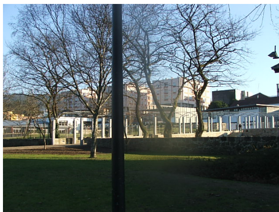
Fig. 9a – As construções urbanas problemáticas em Ponte da Barca, 2007.
